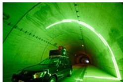
トンネル点検
